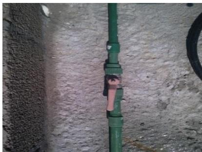
Figura 2 (Llaves de paso en la instalación)
